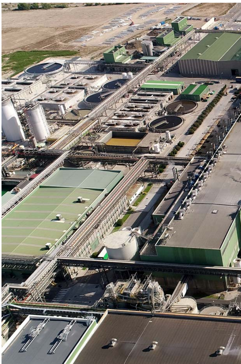
FOTO 3. Depuradora de planta papelerera
